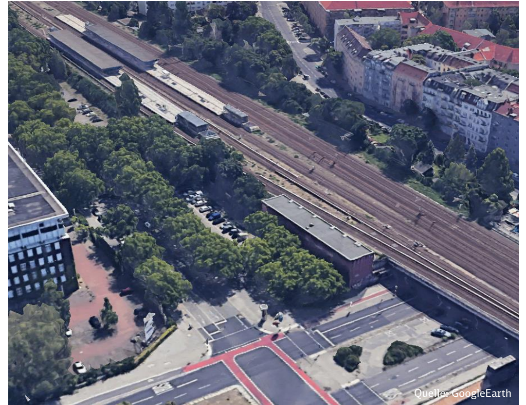
Verkehrsstation Jungfernheide mit Gleichrichterunterwerk (GUw)
